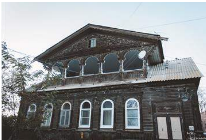
Рис. 1. Памятник архитектуры «Городской особняк», г. Астрахань.
