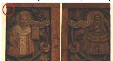
Мал. 7. Наяўны арыгінальны элемент мацавання ліштвы, які паказвае на першапачатковую паўкруглую форму дзвярэй. Вышэй – гарызантальныя накладныя планкі, прымацаваныя ў XX стагоддзі
